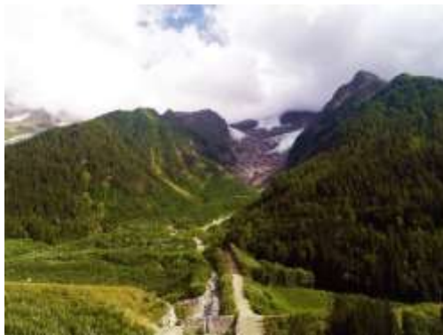
Figura 18 – Central Hídrica de Taconnaz
