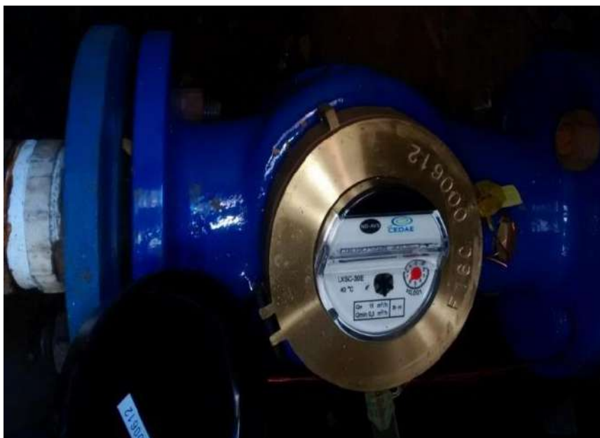
Figura 1 - Hidrômetro referente ao número 485 com vazão de 0,3 - 15 m3/hora.
