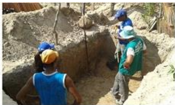
a) Escavação da vala
