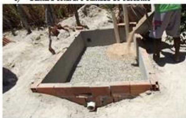
e) Camada de areia grossa sobre a brita
