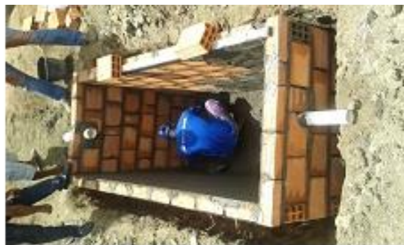
b) Levantamento da alvenaria
