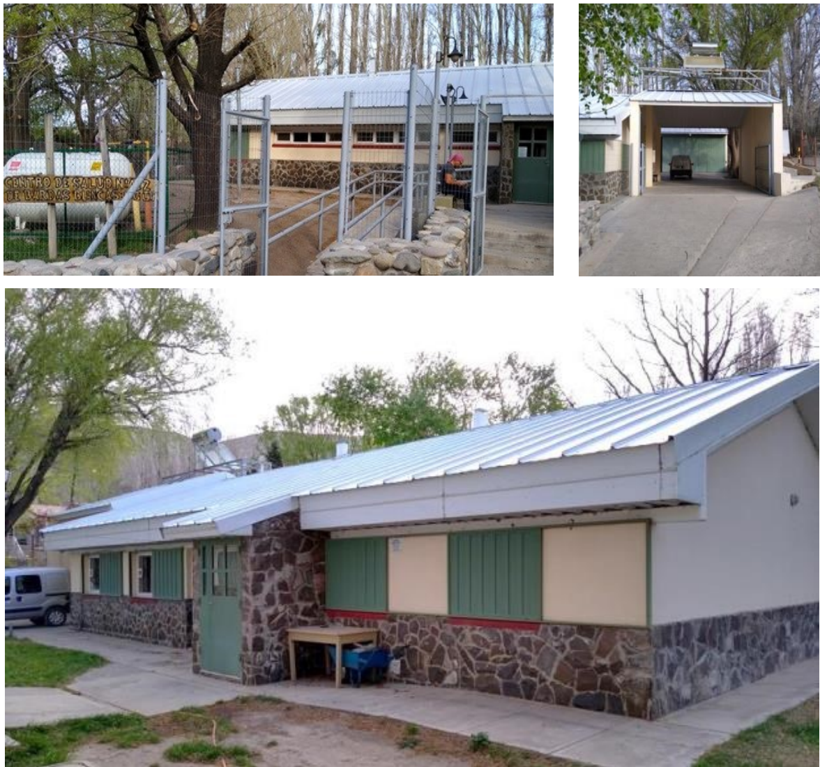
Figura 7. Arriba: intervenciones en fachada norte y construcción del espacio de transición para ambulancias, donde en el techo se observa la colocación del panel solar para la producción de agua caliente sanitaria. Abajo: fachada sur del edificio, donde se puede observar que el ingreso avanza sobre la línea de fachada por la construcción de la exclusiva o puerta-trampa y el uso de postigos en ventanas. Fuente: autores
