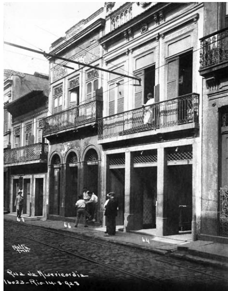
Fig. 9. Rua da Misericórdia, 1928. (Augusto Malta / Brasileira Fotográfica).
